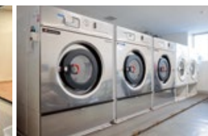
大型の洗濯機、乾燥機を設置
